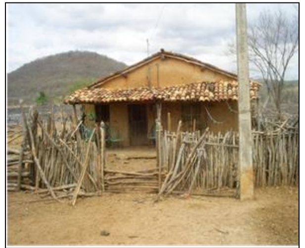
Foto 12 - Rede elétrica de baixa tensão que atende os imóveis da área da bacia hidráulica do futuro reservatório (E-303.021; N-9.579.283).
