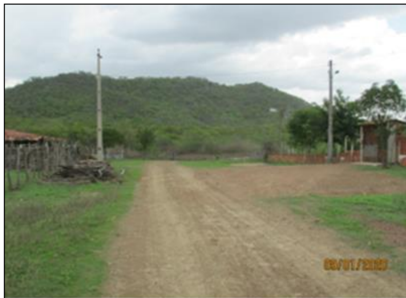
Foto 23 – Via de acesso e rede elétrica que atendem as áreas das alternativas posicionadas nas localidades de Melancia I e Melancia II.
