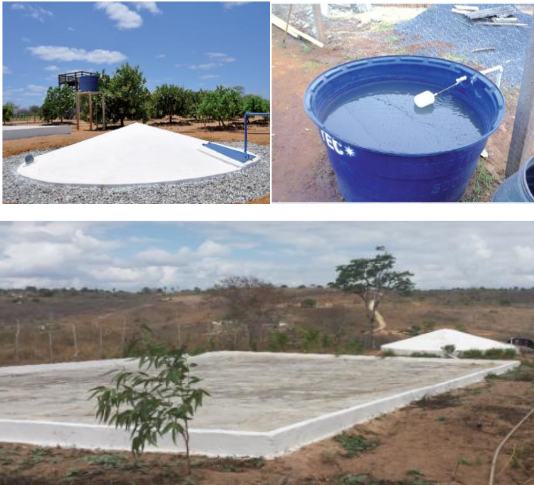
Figura 3.8 - Modelos de Caixas d'Água e Cisternas que Podem Ser Utilizadas no Armazenamento de Água para Uso na Irrigação das Hortas.
