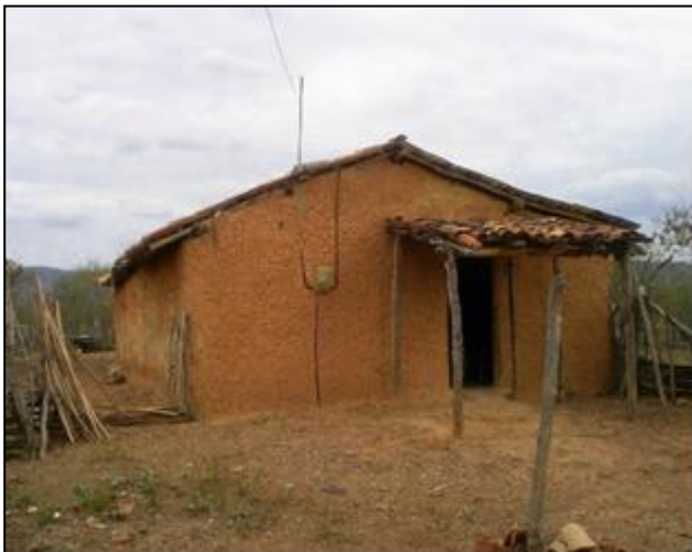
Foto 11 – Habitação de taipa na área da bacia hidráulica do futuro reservatório (E-300.897; N-9.577.488).
